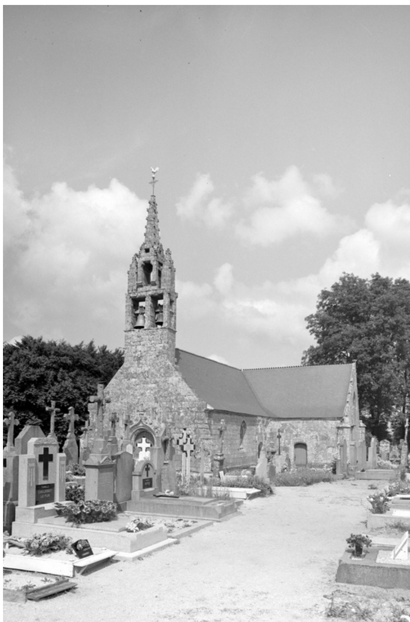
Vue de situation prise du sud ouest
