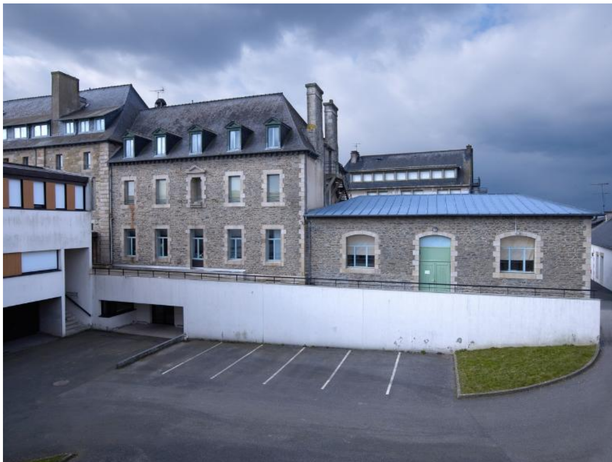
Maison et remise construites au 19e siècle en alignement du grand corps de logis. Vue générale sud
