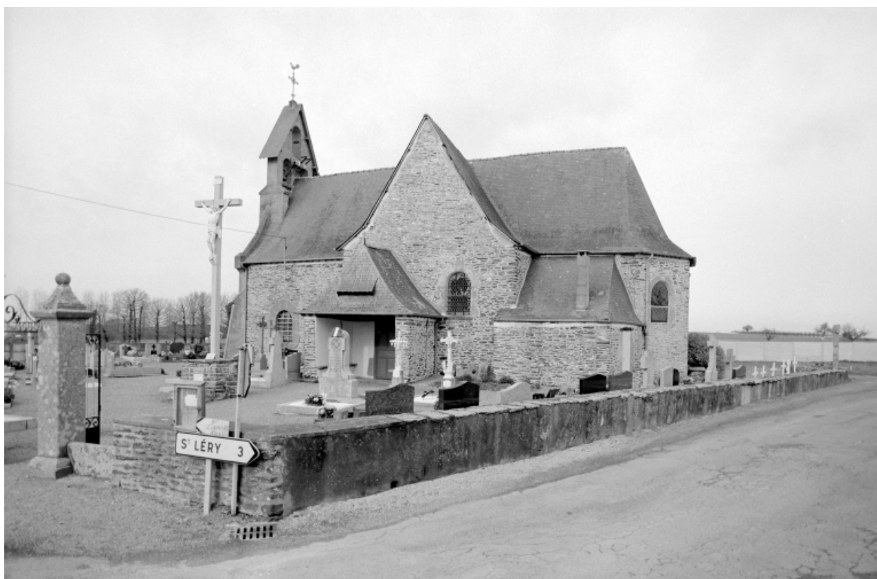
Elévation Sud : vue générale
