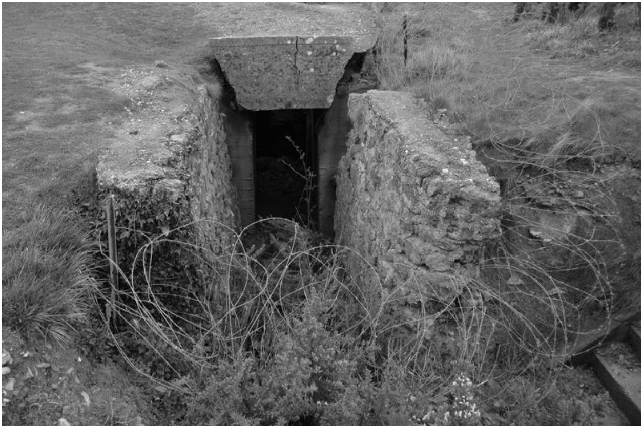
Vue de la batterie de Grandcamp-Maisy, pointe du Hoc : entrée d'un abri
