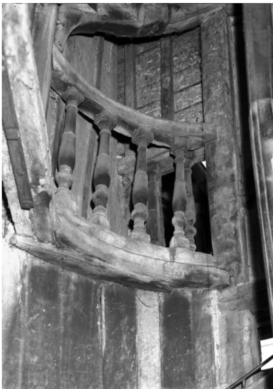
Escalier : vue générale
