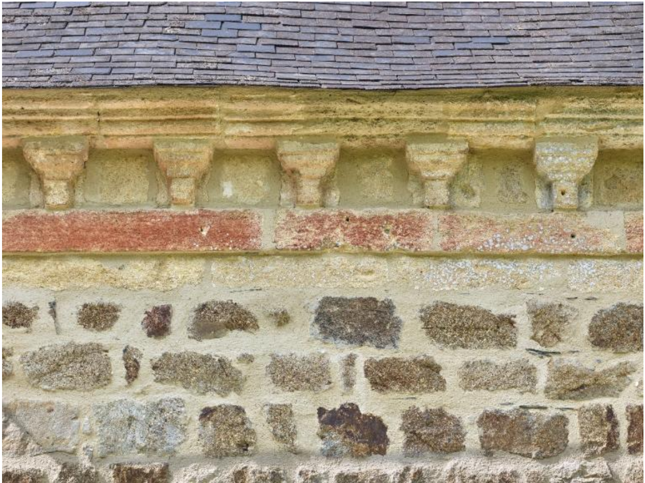
Façade de la dépendance ornée de corniches et bandeau coloré
