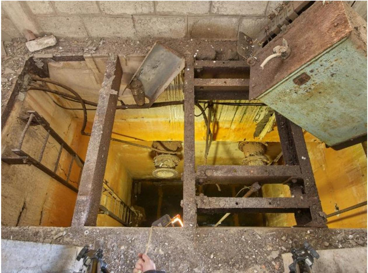
Vue de la salle des pompes de l'alvéole D (quai n° 19) aménagée dans l'épaisseur du mur de refend : fosse technique en sous-sol au niveau des commandes des pompes
