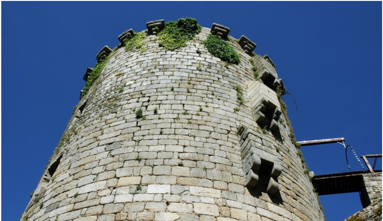
Vue de la tour nord dite dite tour de Rougé : détail des trois latrines en encorbellement
