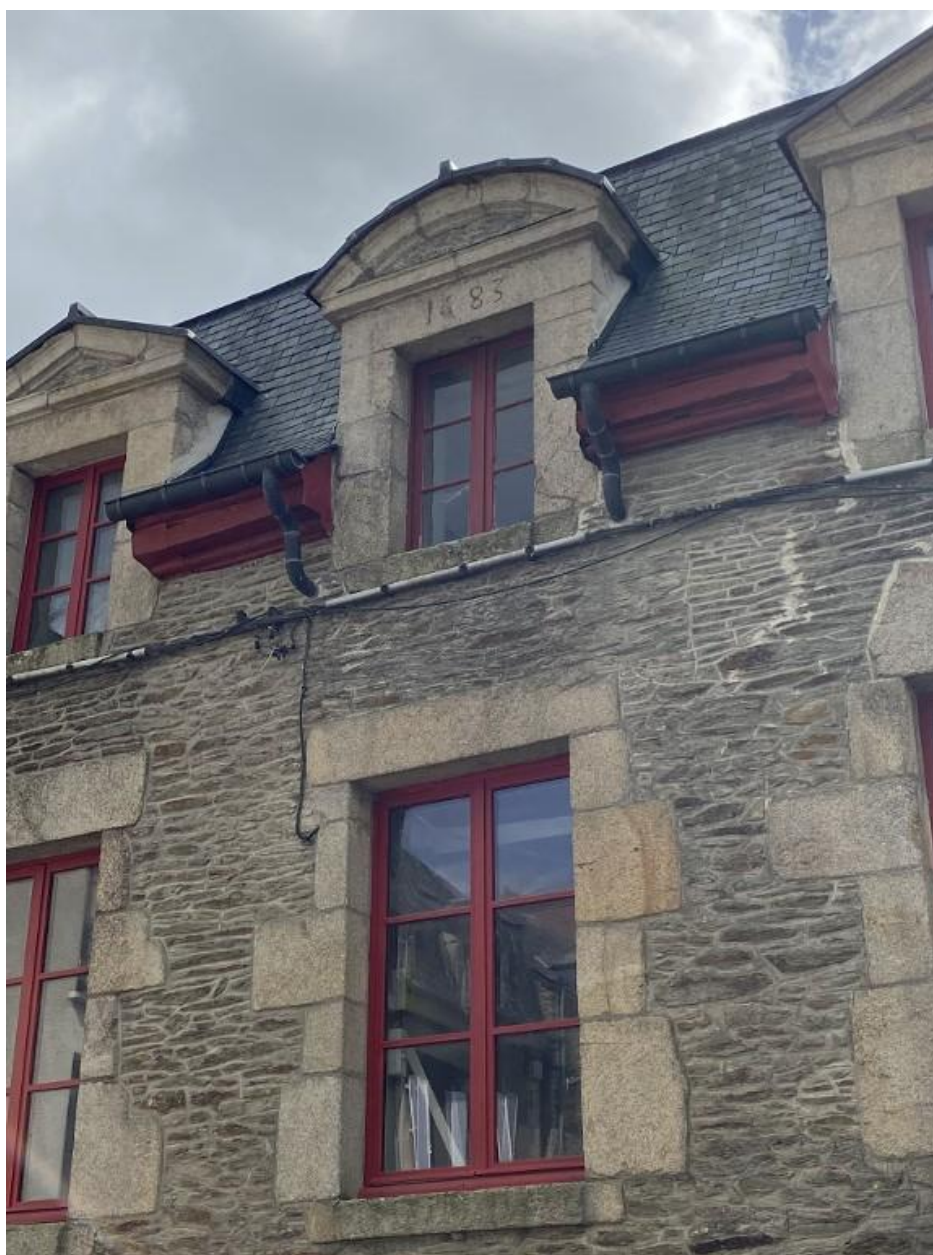
Linteau daté, détail, vue nord-ouest
