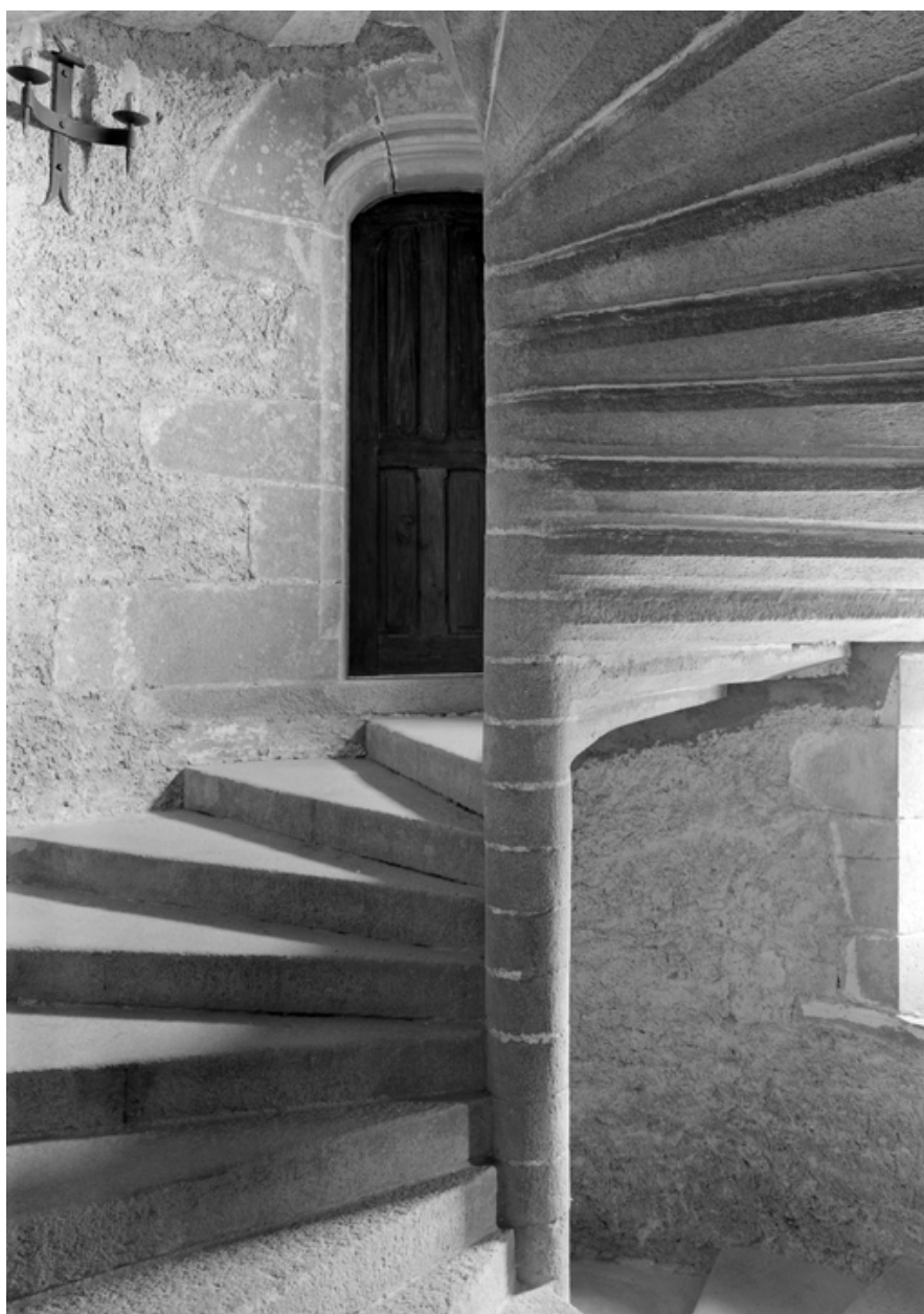
Tour d'escalier : vue générale de l'escalier (état en 1984)
