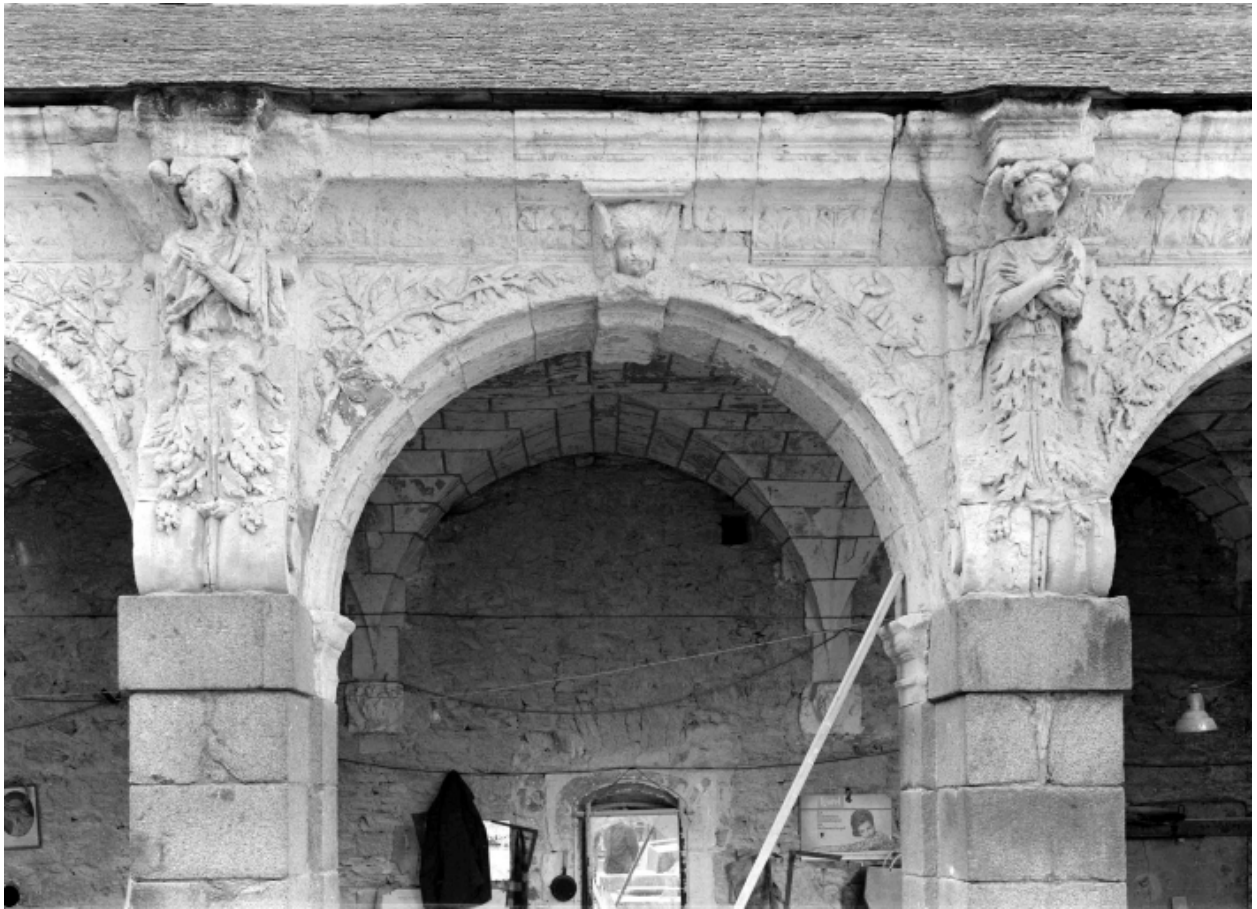
Détail sur la troisième arcade ouest
