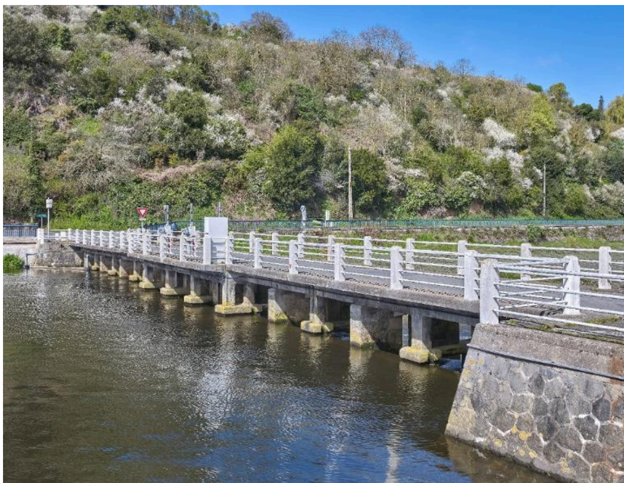
Pont-déversoir du bassin à flot
