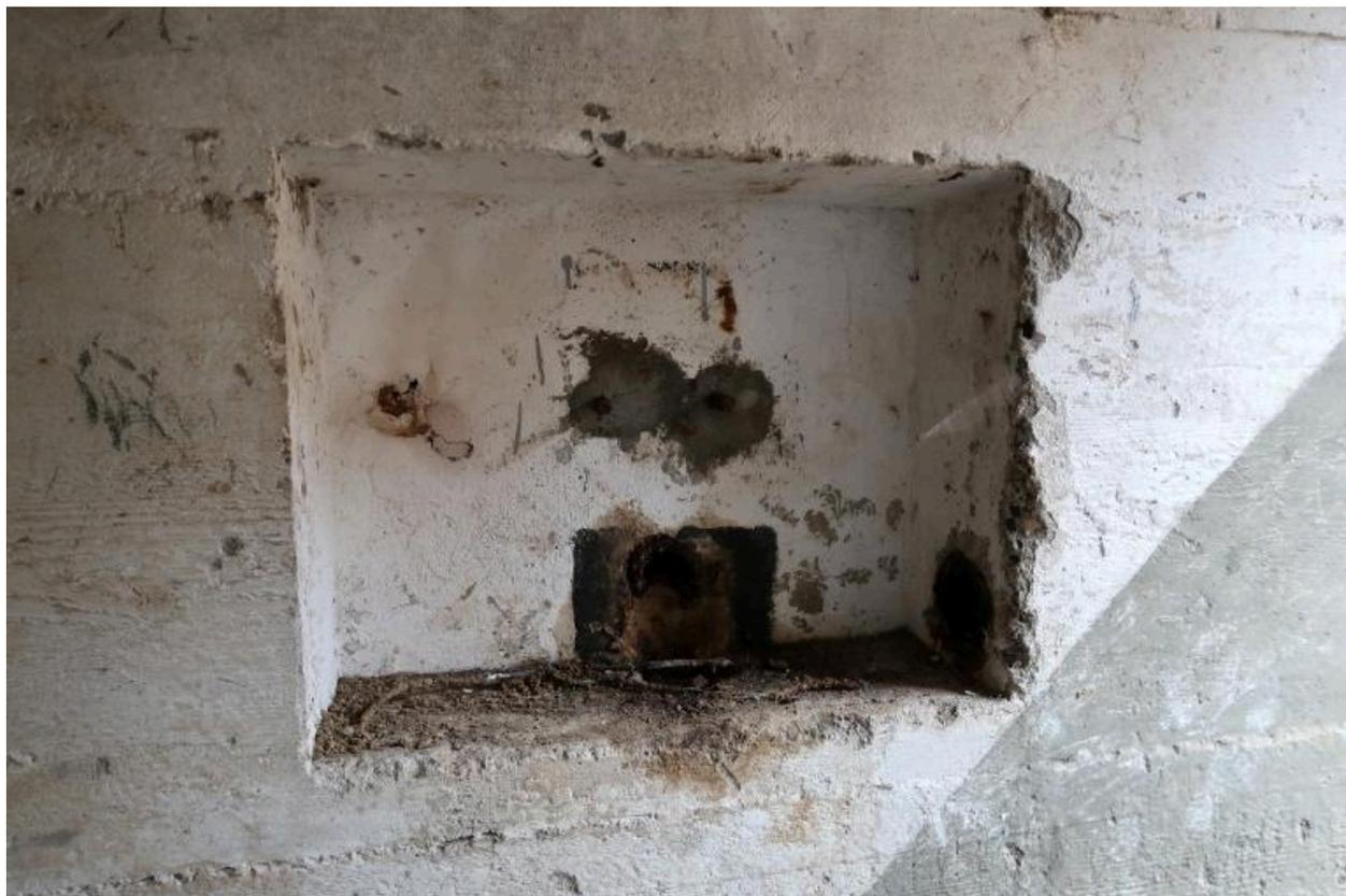
Vue de l'entrée nord : niche murale avec passage de câble et fixations (mur nord). Sur le mur, peinture murale en biseau pour éviter le repérage de l'entrée du bunker depuis le ciel
