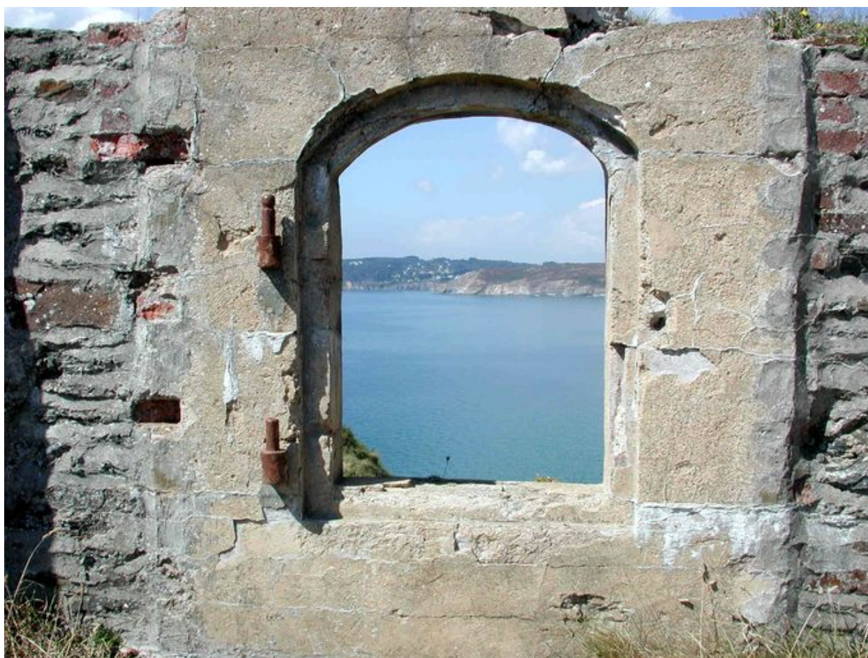
Vue du réduit de batterie de côte de l'île de l'Aber : terrasse, embrasure
