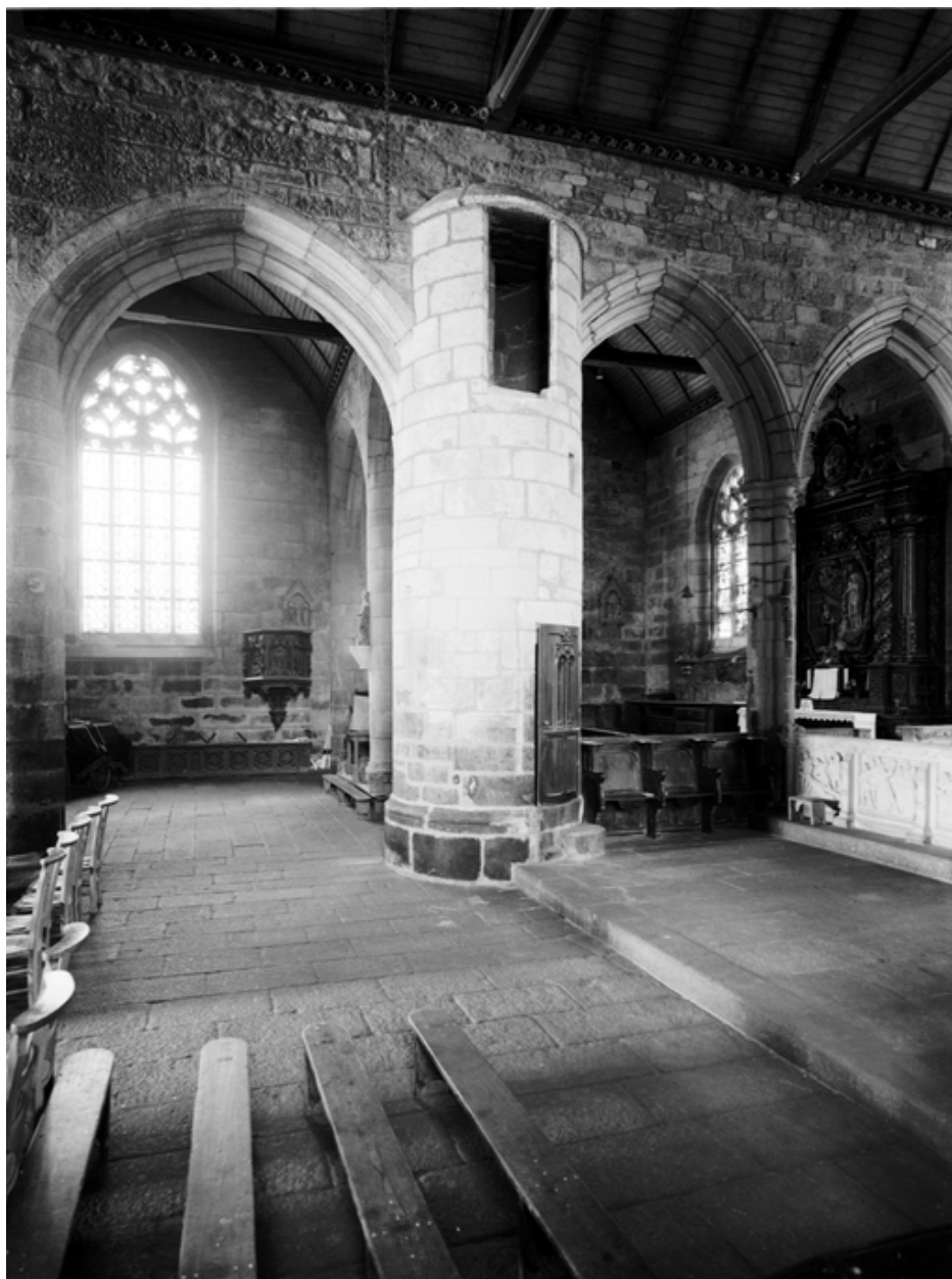
Pile d'accès au jubé détruit
