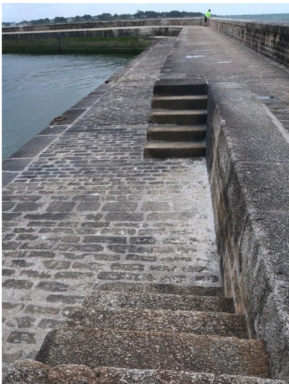
Môle de la Croix, escaliers et paliers
