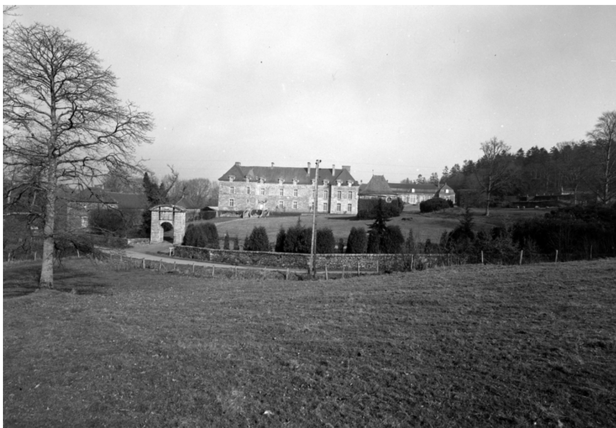
Vue de situation sud
