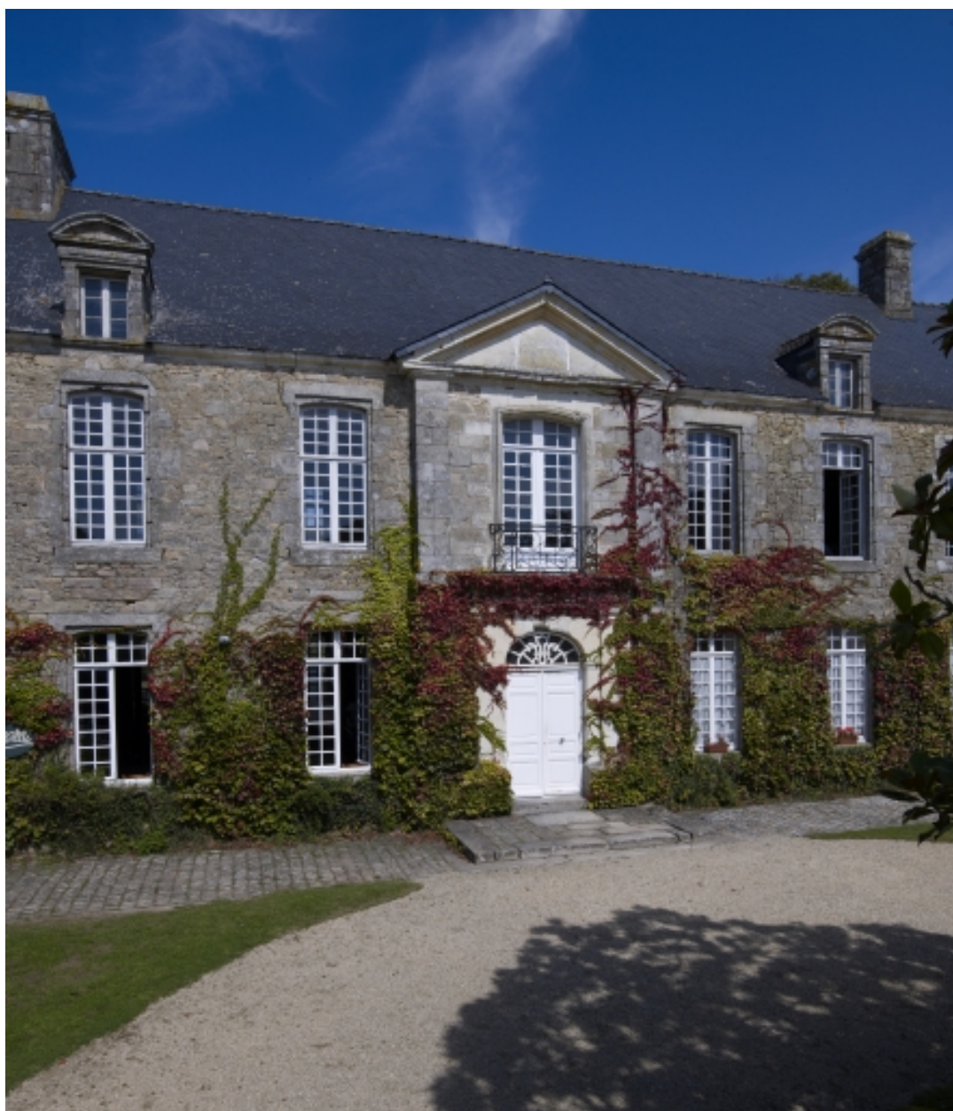
Elévation sud, détail des travées médianes
