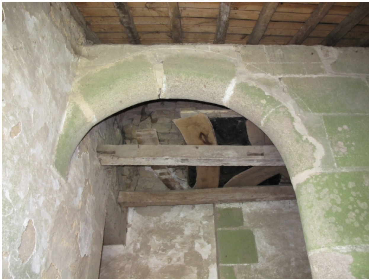
Arc de l'escalier
