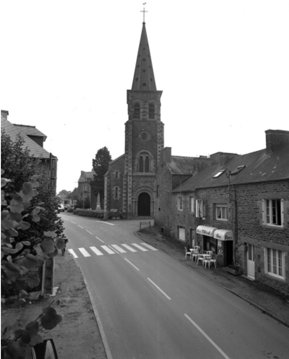
Vue générale est
