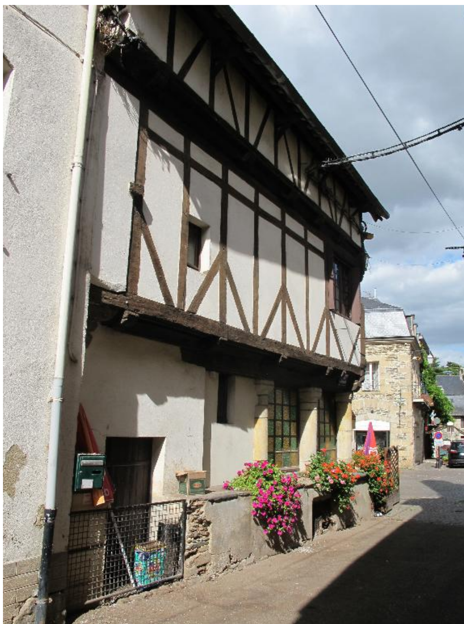
Maison : élévation est vue du sud (état en 2012)
