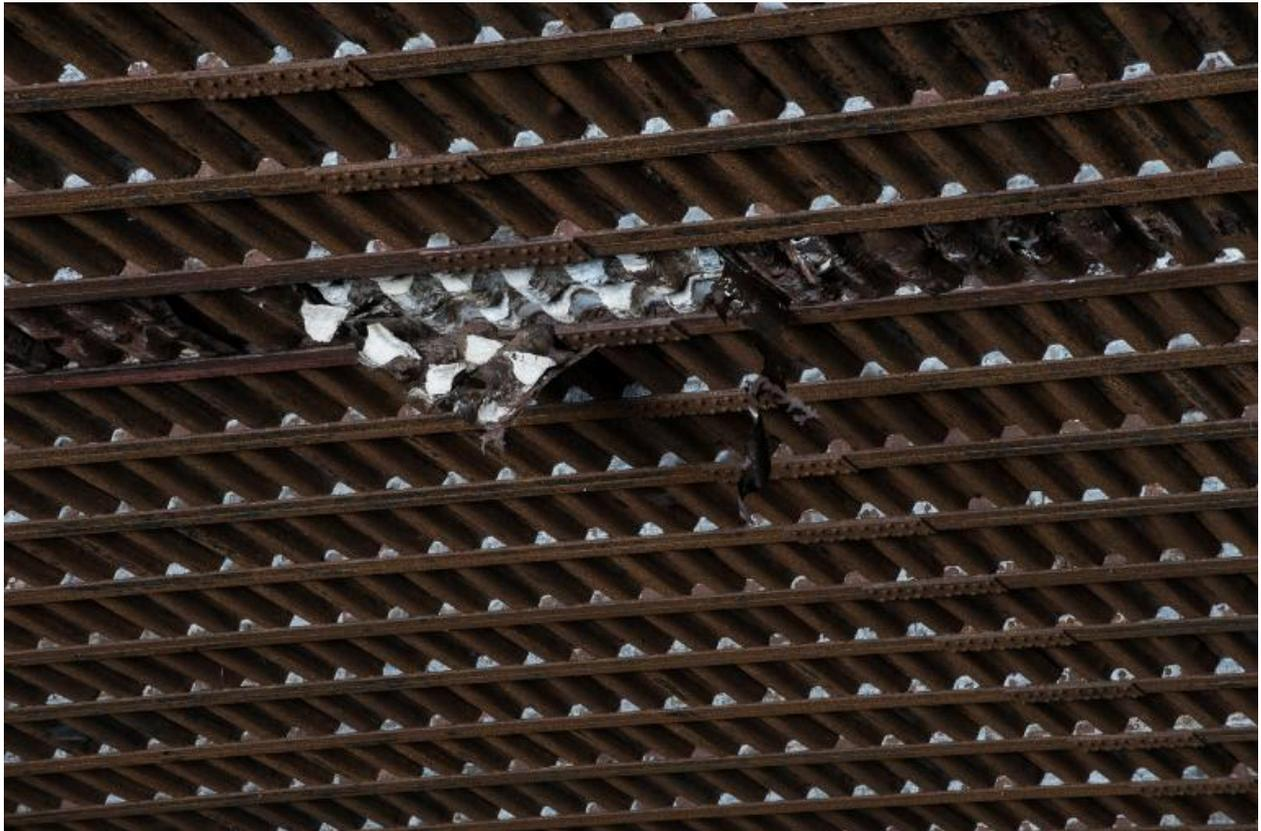
Vue de détail du plafond en tôles nervurées en acier de l'une des deux alvéoles
