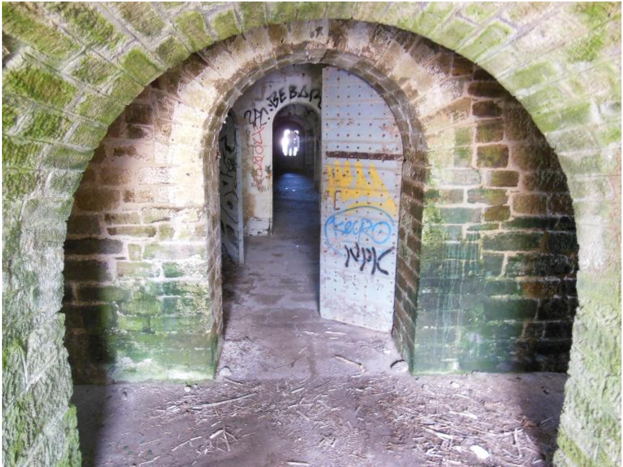
Le Palais, pointe de Taillefer, corps de garde crénelé, magasin d'artillerie et accès extérieur rajouté.
