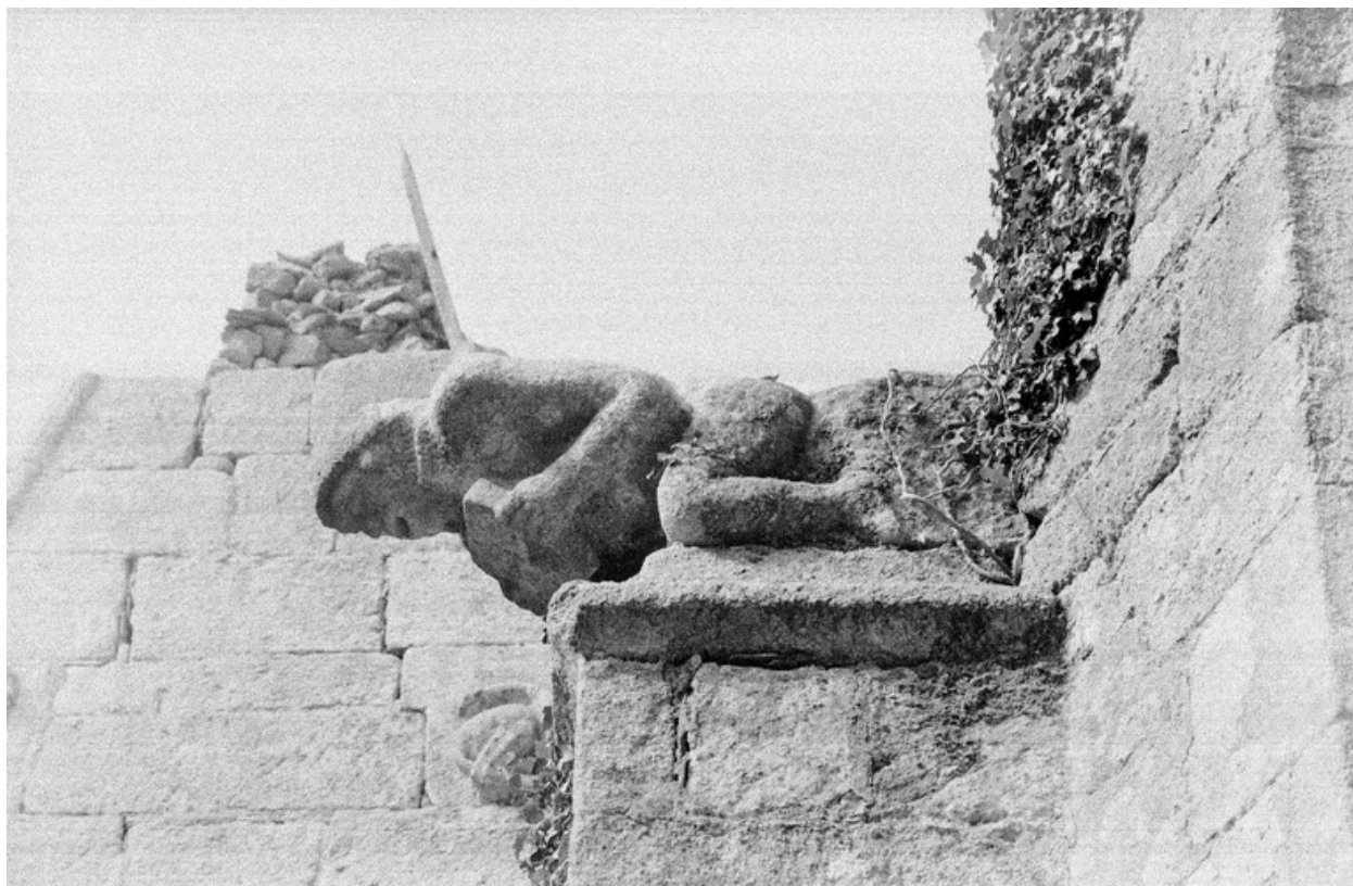
Contrefort sud du chevet, détail : vue de la gargouille
