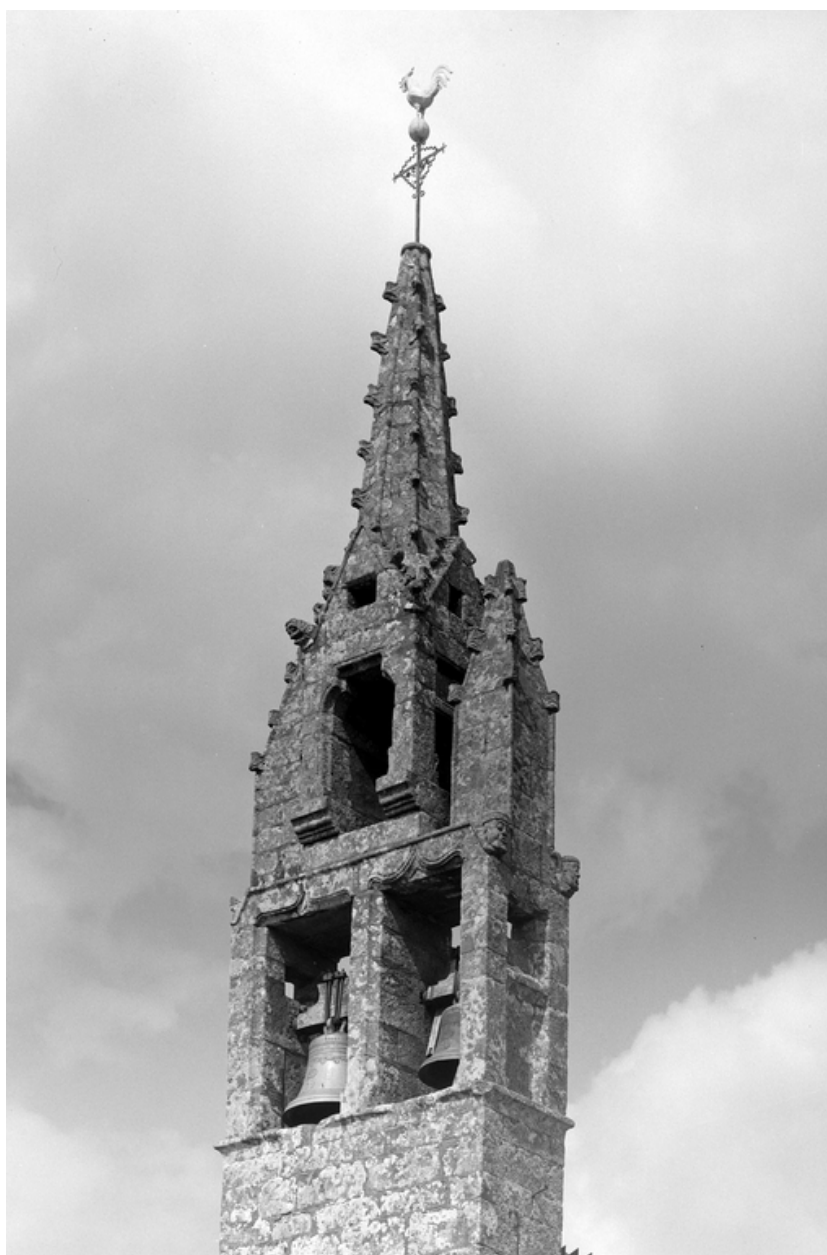
Clocher : vue générale prise du sud ouest
