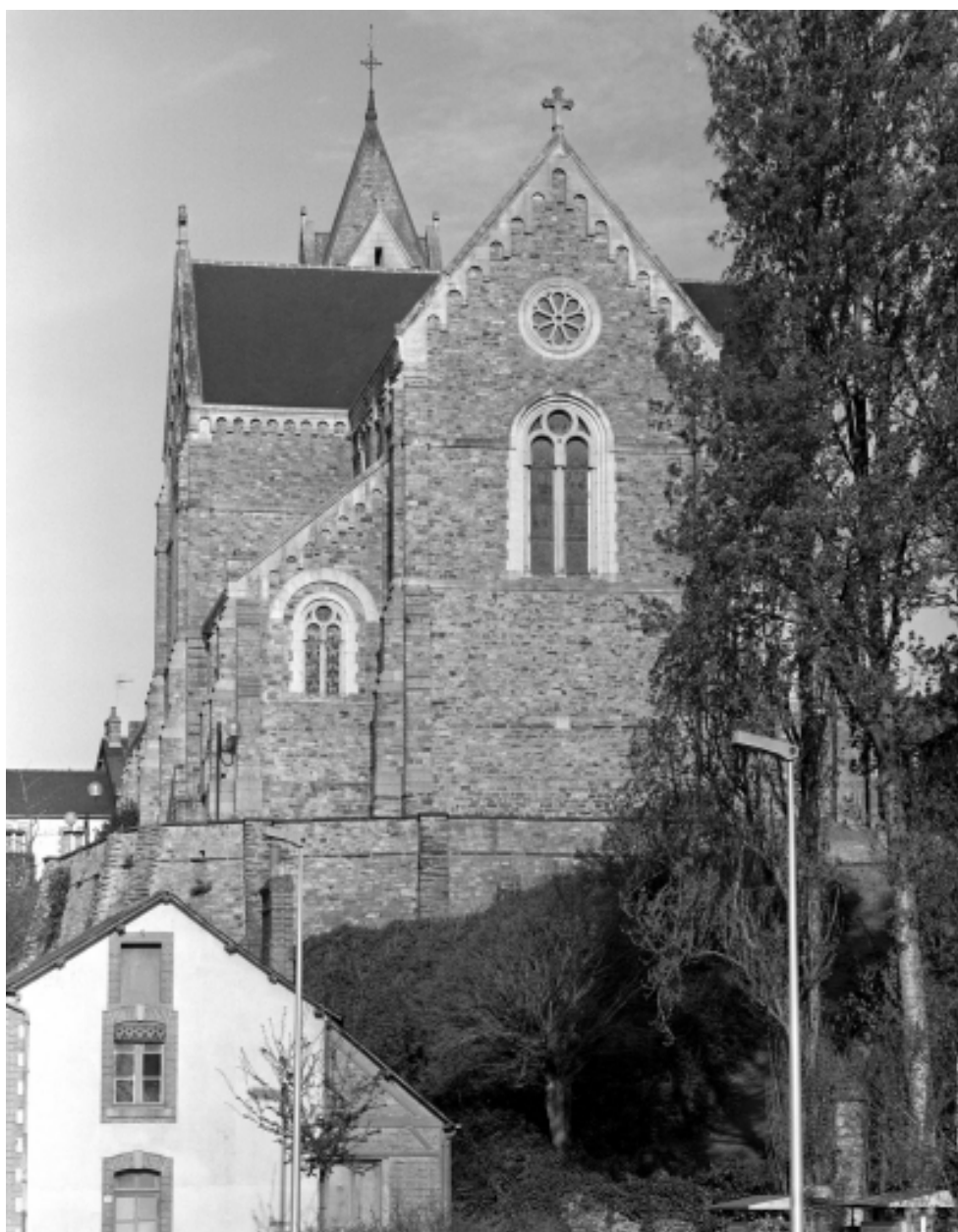
Vue générale est
