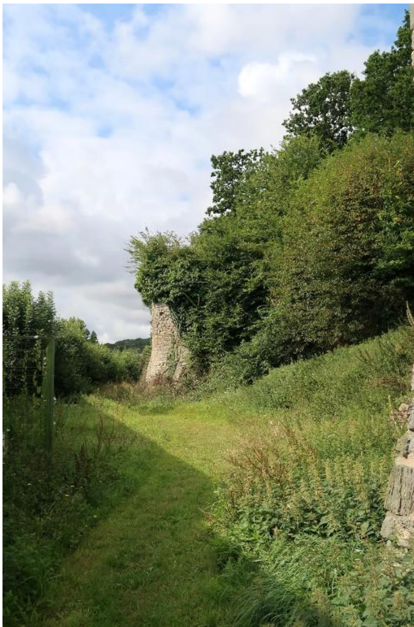
Vue du front est : tour intermédiaire est
