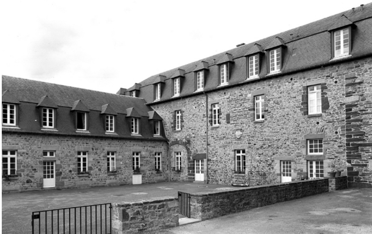
Ancien manoir abbatial ; façade sur la cour
