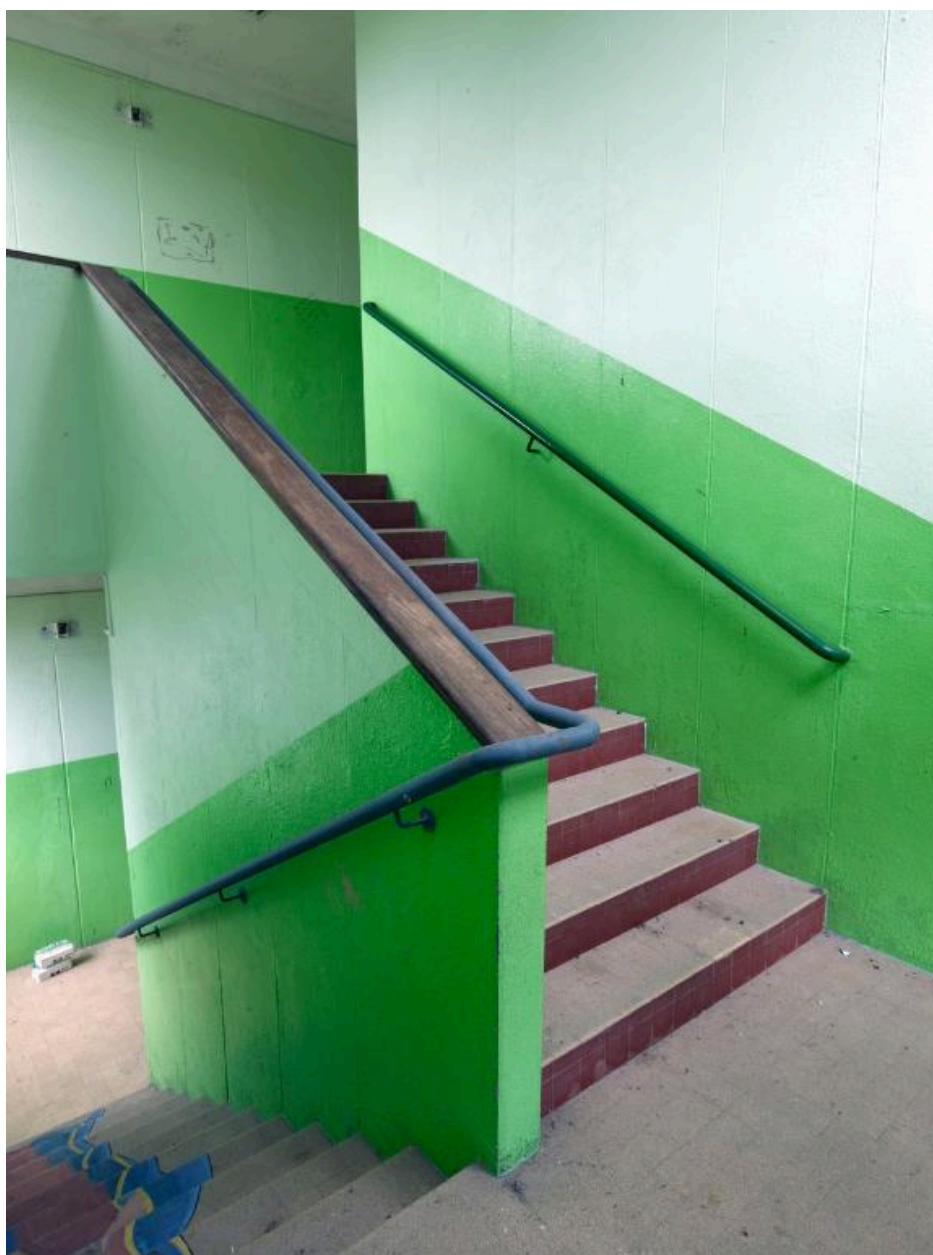
Cage d'escalier nord-ouest, internat de garçons (1954), désaffecté.
