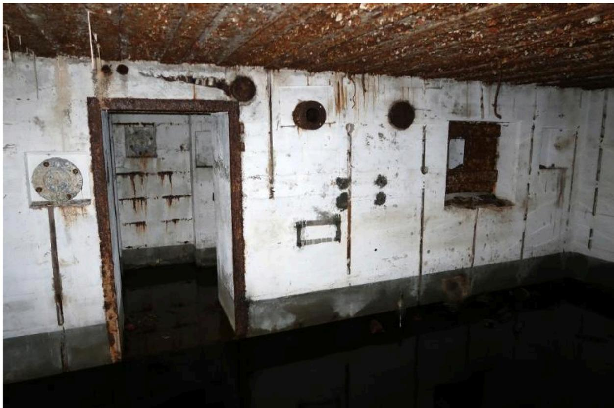
Vue intérieure : salle de garde sud. La porte débouche sur le sas. A gauche, bouche de surpression à clapet à contrepoids en aluminium ; au centre, emplacement du ventilateur [disparu] ; à droite, créneau blindé de défense
