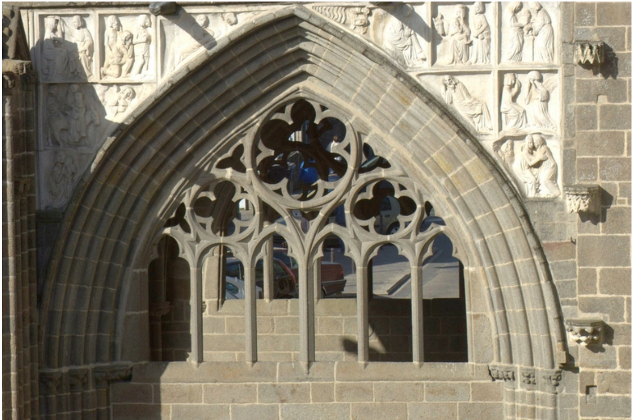
Porche sud, face est, détail réseau
