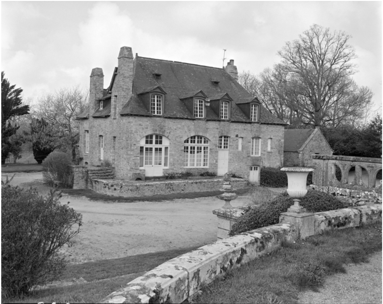
Vue générale de l'orangerie.
