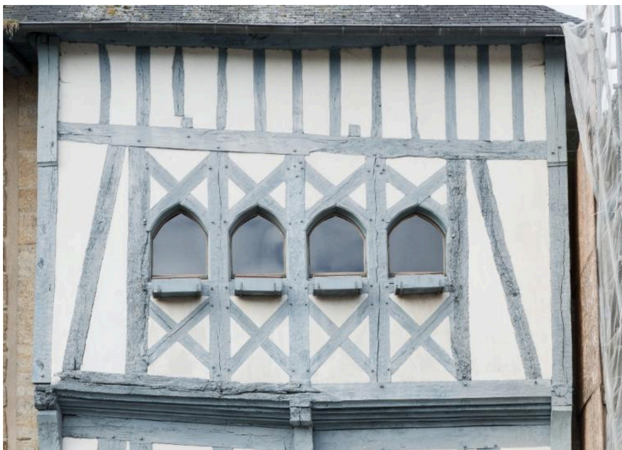
Deuxième étage contreventé d'écharpe avec quatre fenêtres restituées.
