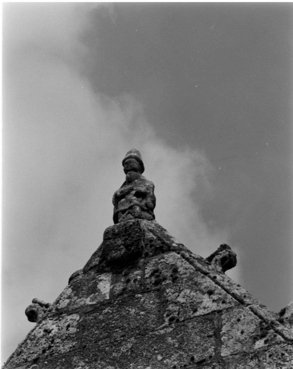
Pierre d'amortissement du bras sud du transept
