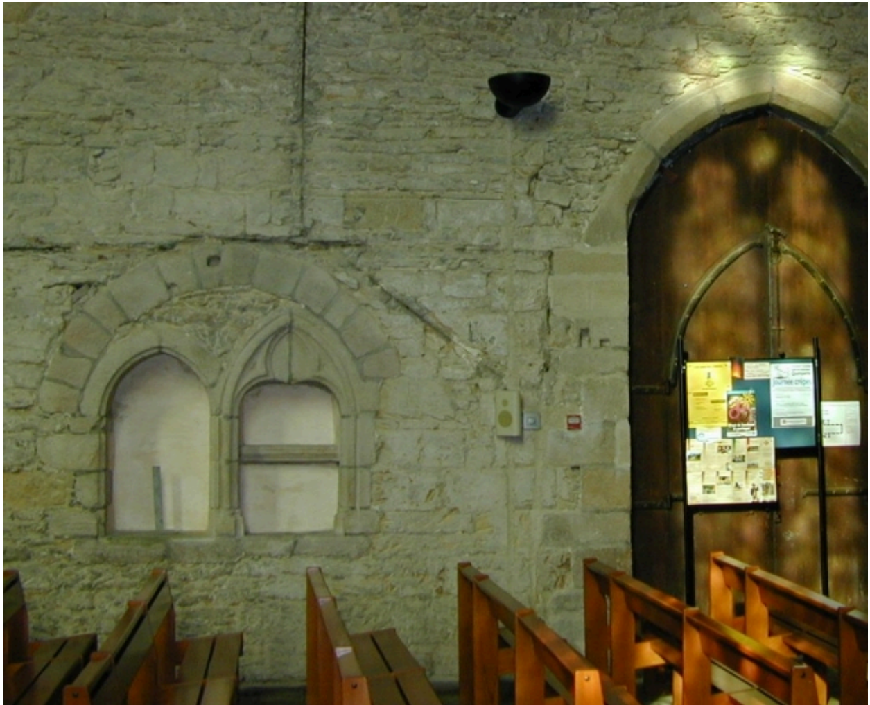
Nef, mur nord, détail
