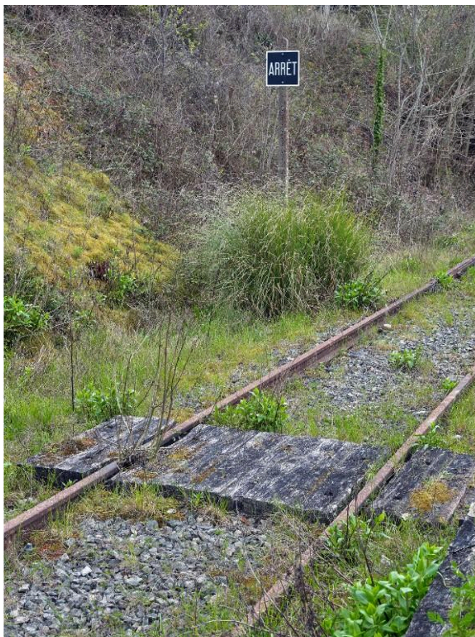
Vestige du réseau ferré du port
