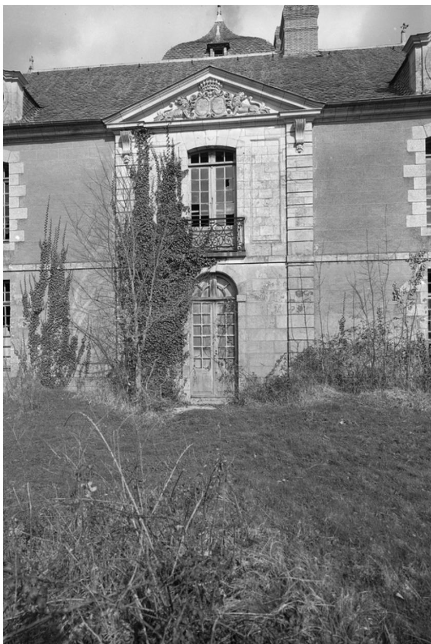
Elévation sud avant corps central.
