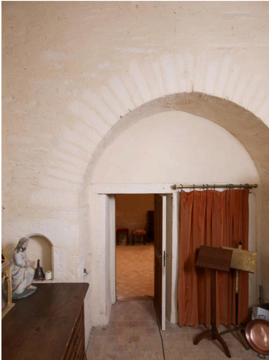
Eglise Saint-Melaine, vue intérieure de l'élévation sud de la sacristie Saint-Gilles
