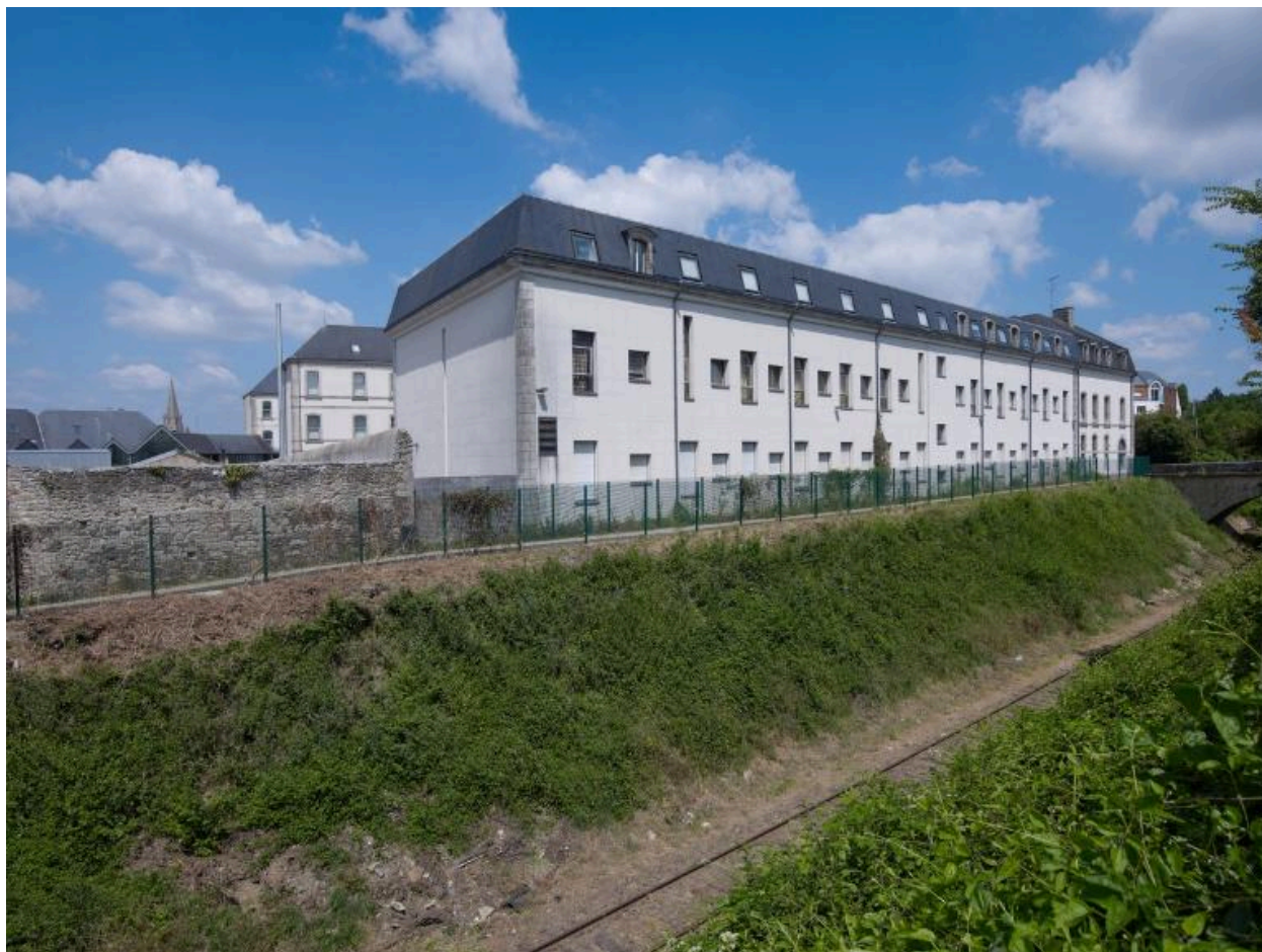
Façade côté voie ferrée du bâtiment A1 (externat et gymnase) reconstruit en 1989-1990 (H. L'Hyver, architecte).
