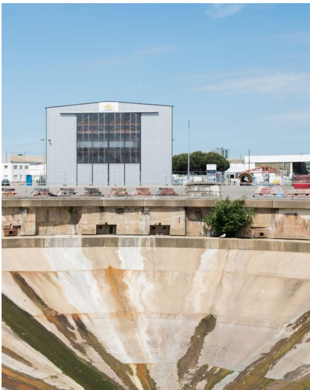
Vue de la fosse du slipway vers le nord
