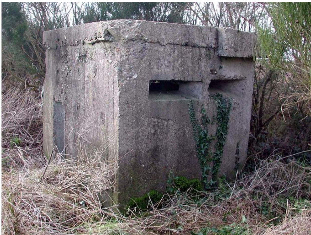
Vue d'un poste d'observation et de tir en béton armé (état en 2007)
