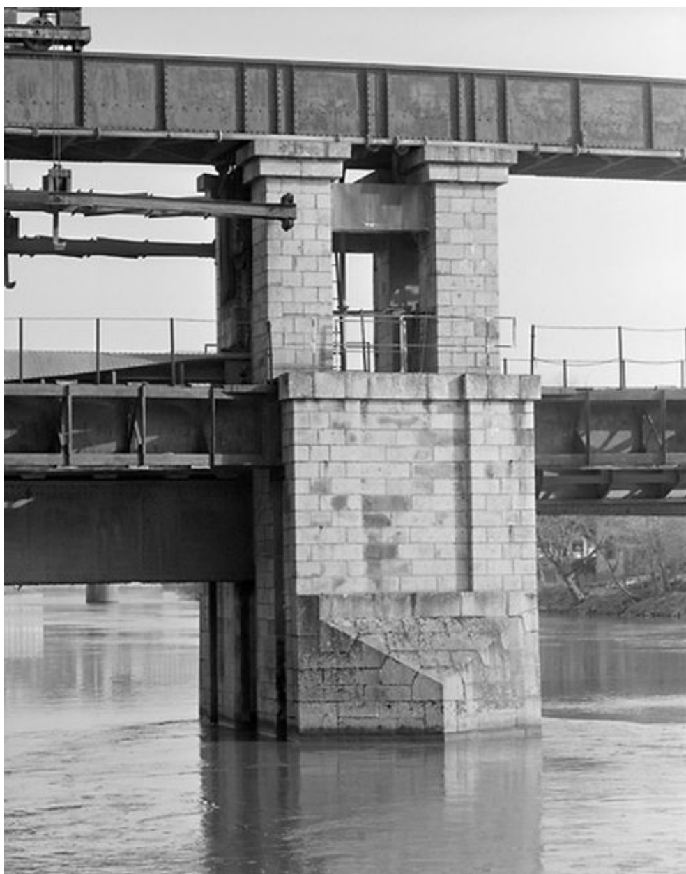
Grand Vannage : vue générale d'une pile
