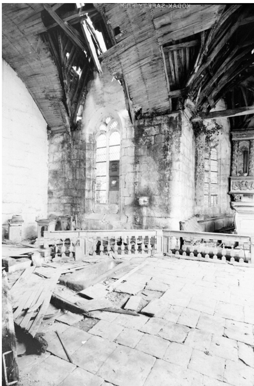
Croisée du transept : vue de l'angle nord-est
