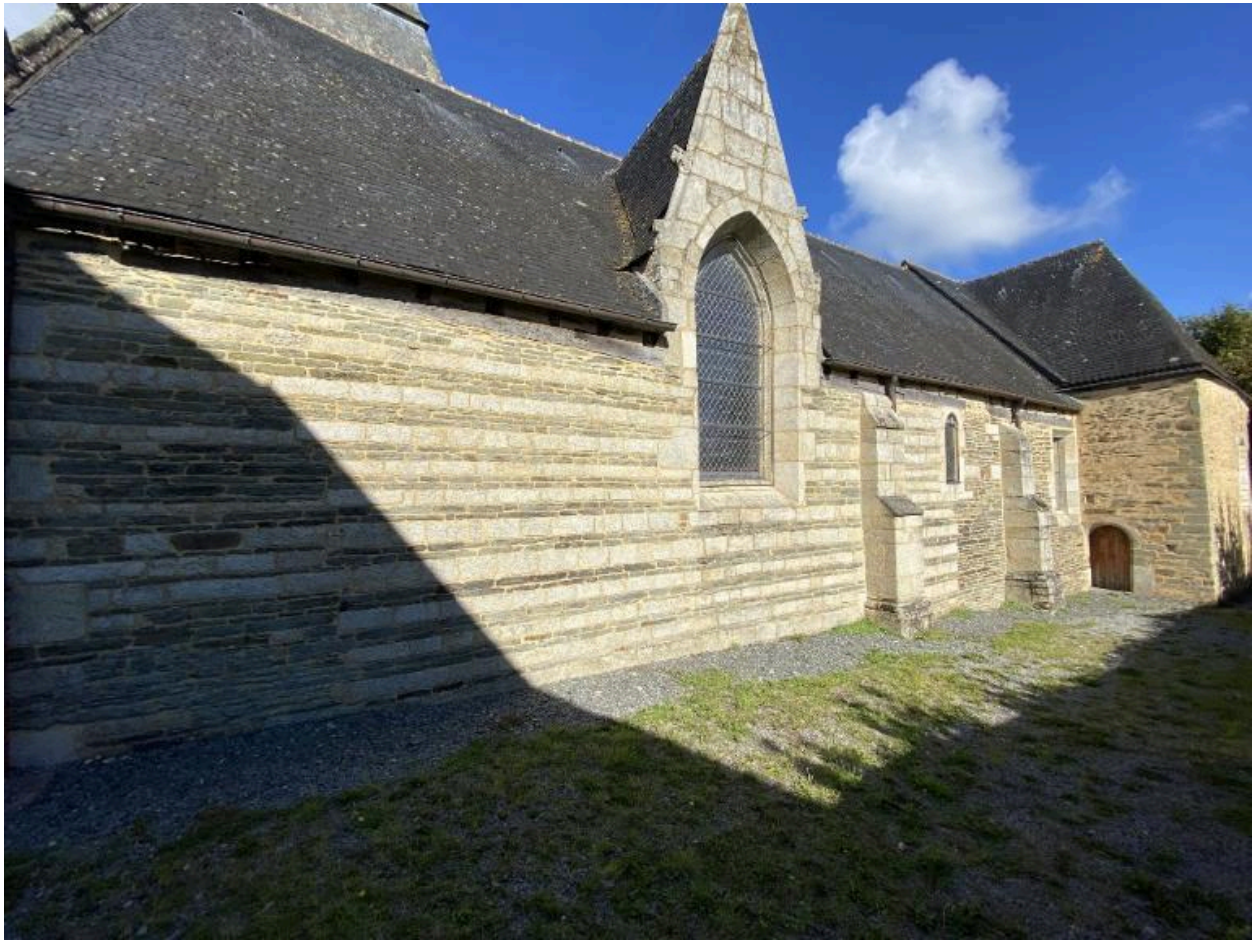
Élévation sud, vue générale
