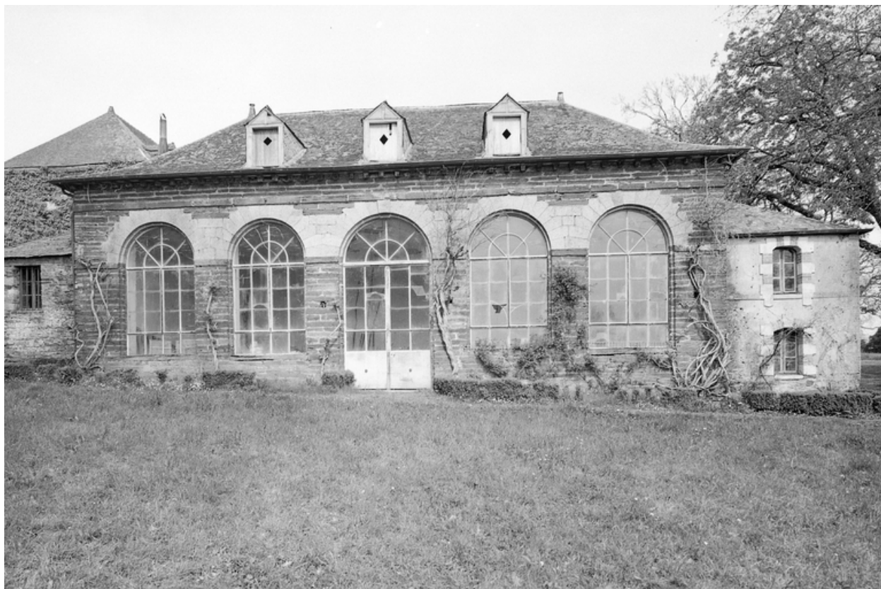
Vue générale sud de l'orangerie.
