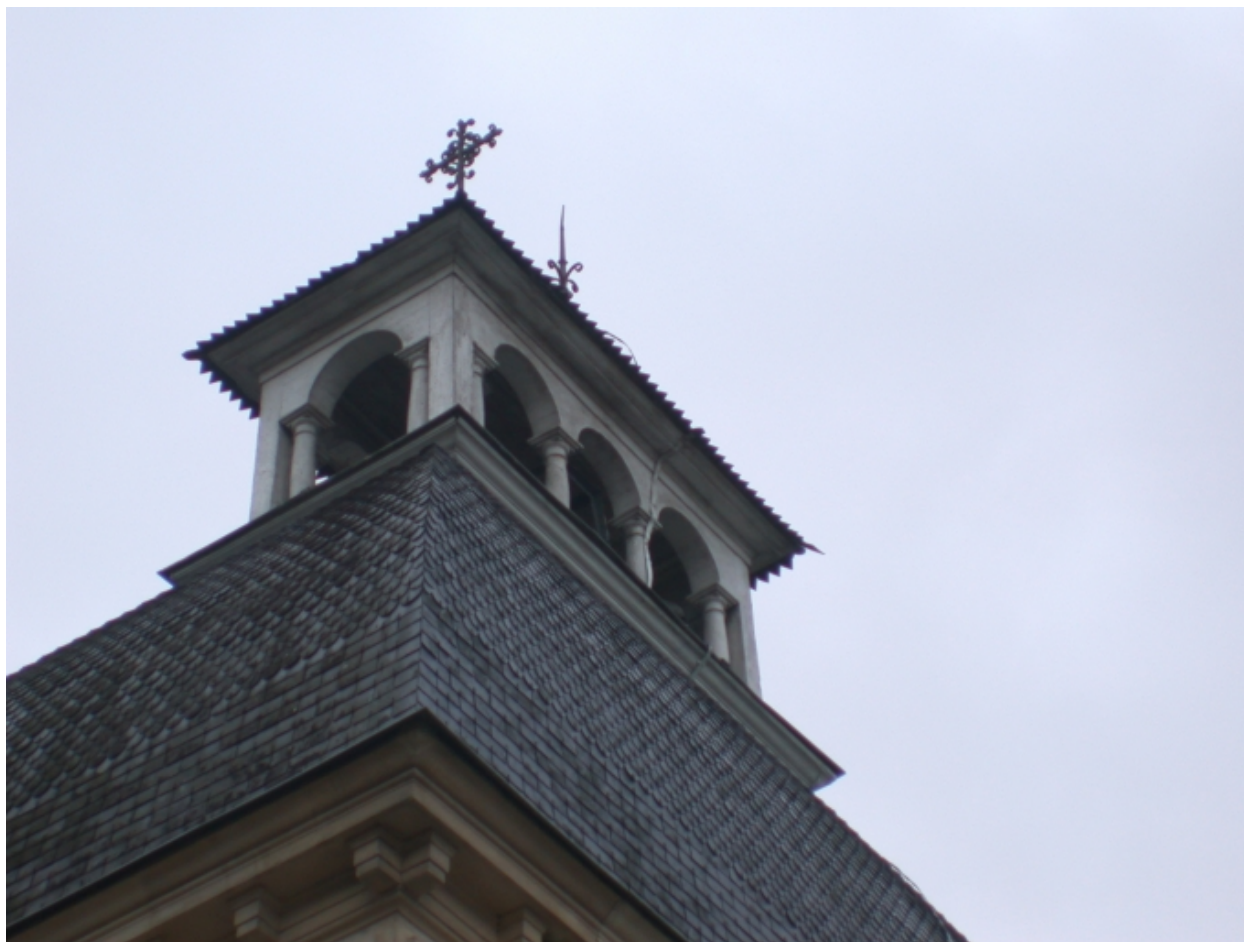
Campanile de la chapelle
