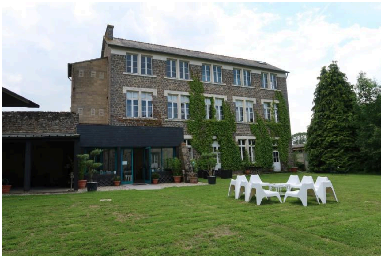
Le Bâtiment de formation
