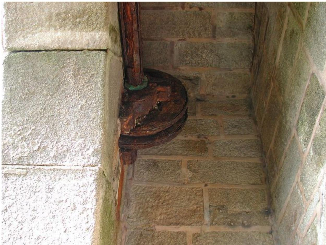
Vue de la poulie gauche du pont levis à chaîne et contre-poids (état en 2000)
