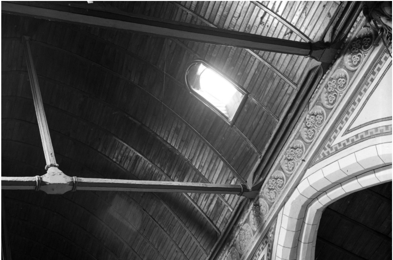
Nef, vue de détail des parties hautes.
