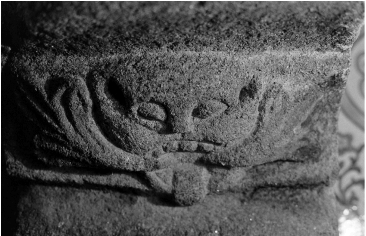
Cheminée du rez-de-chaussée, détail du corbeau
